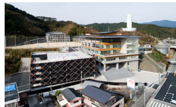
高台移転が完了した中土佐町役場庁舎
