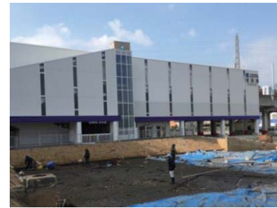
▲駅舎整備工事の様子
