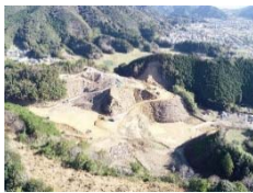
高台での庁舎建設工事
