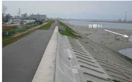
現状の堤防写真
