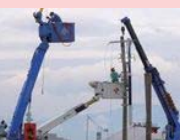
配電線復旧訓練
