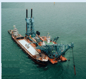
浚渫工事状況写真
