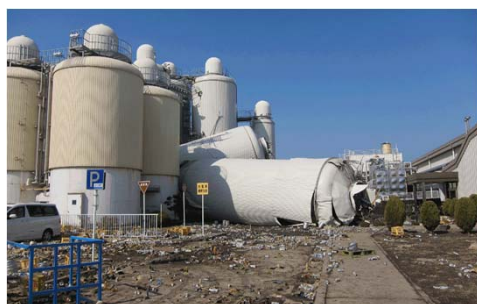
ビールタンクの倒壊状況
