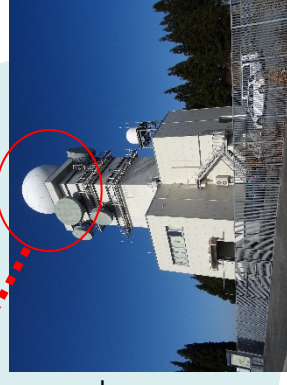
CバンドMPLレーダ雨量計 (アンテナ直径:約4m)
