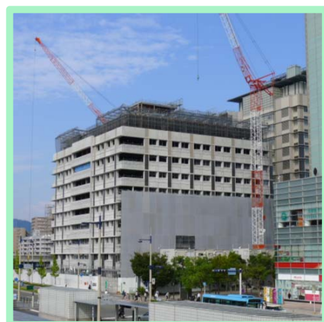
（工事進捗状況：H28年9月9日撮影）
