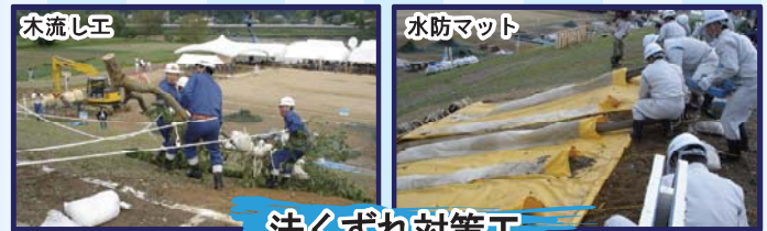
法くずれ対策工
