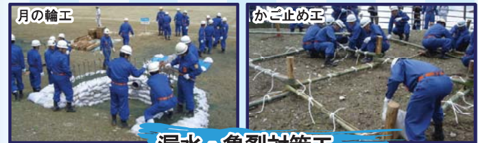
漏水・亀裂対策工
