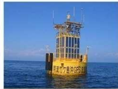
沖合ブイ設置状況
