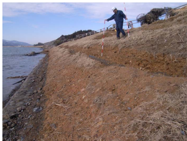
津波遡上時の高流速によって侵食された堤防表のり面
