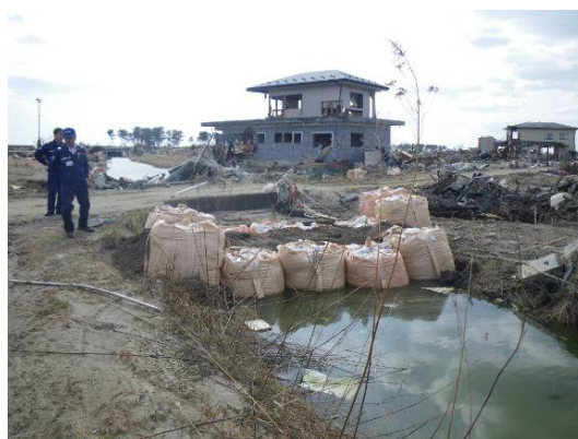
土のうを使って浸水エリアを分断
