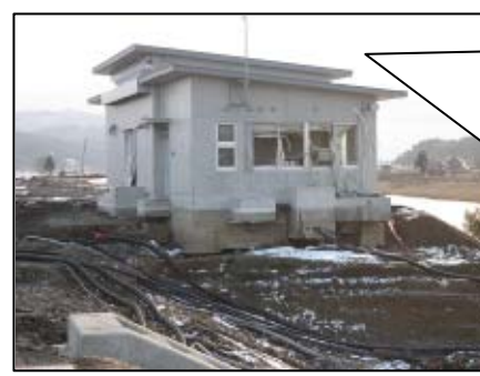
月浜第一水門局舎
