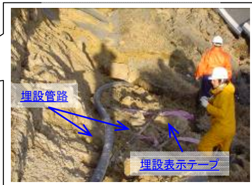
光ケーブル埋設管路 崩壊状況
