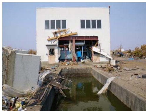
雨水排水ポンプ場の現地調査
