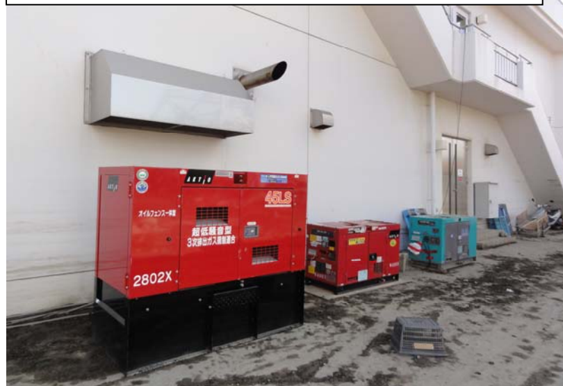
仮設発電機による電源復旧（東北技術事務所）
