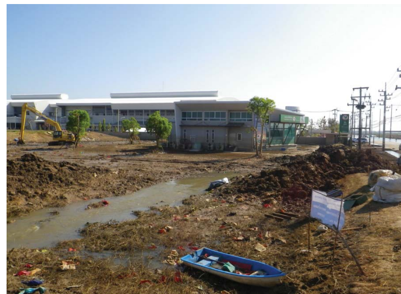
11月26日(土)排水後
