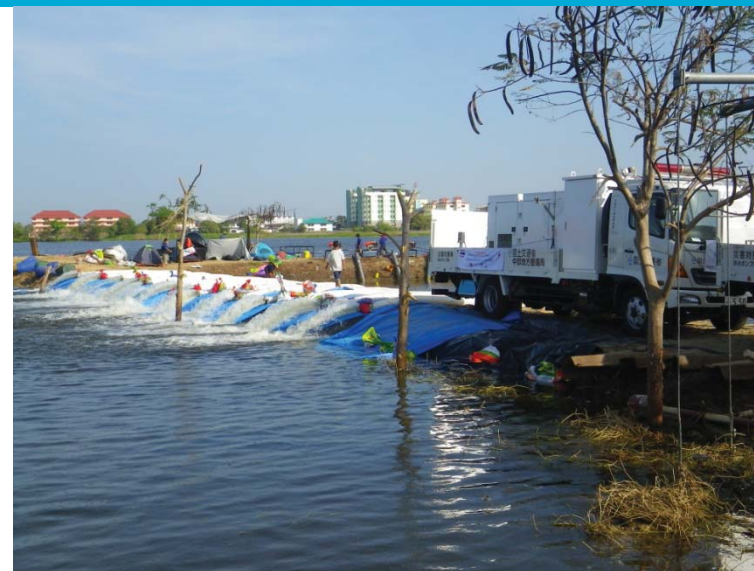
11月20日(日)ポンプ排水状況
