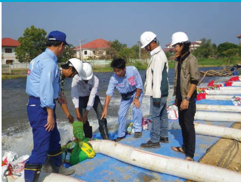
11月20日(日)ポンプ調整状況
