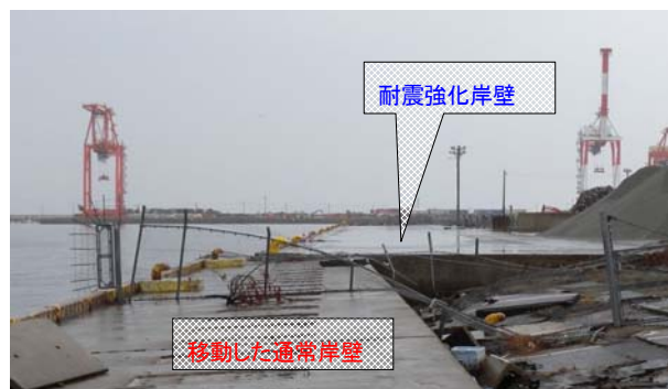
◇耐震強化岸壁(仙台塩釜港 仙台港区)
