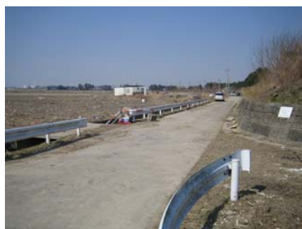
◇仙台東部道路より陸側（西側）
