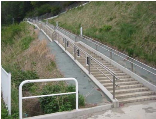
◇国道45号に配置された、小本小学校 津波避難階段（岩手県岩泉町）
