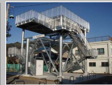
・津波避難タワーの整備
