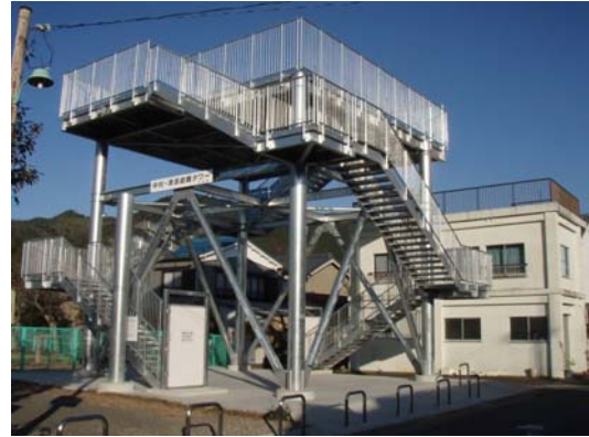
◇津波避難タワー（徳島県海陽町）
