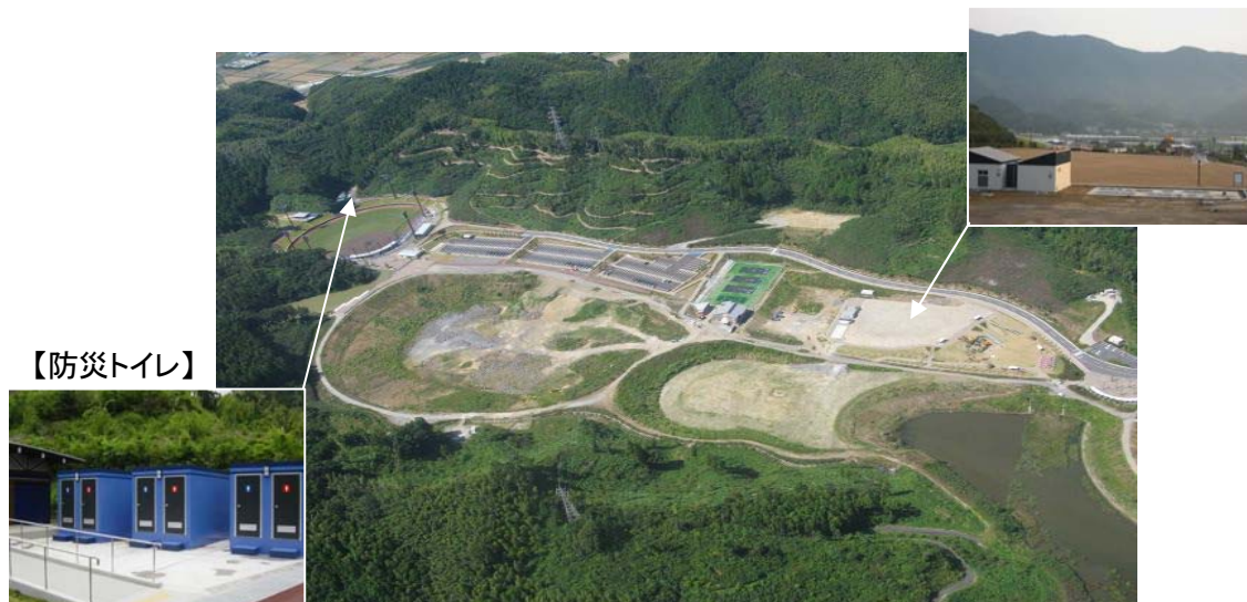
◇ 防災拠点としても活用できるよう整備された施設(阿南市南部健康運動公園)
