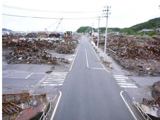
※気仙沼：道路啓開後も路面標示は健全
