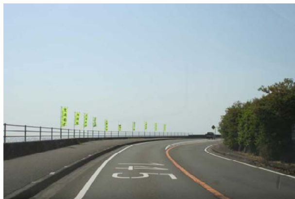
※道路パトカーからみた対空標示
