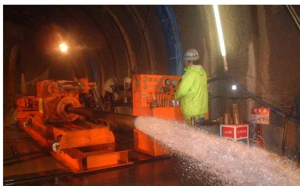
水平調査ボーリング時の湧水状況
