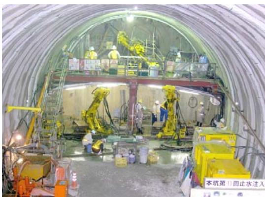
止水注入工の施工状況
