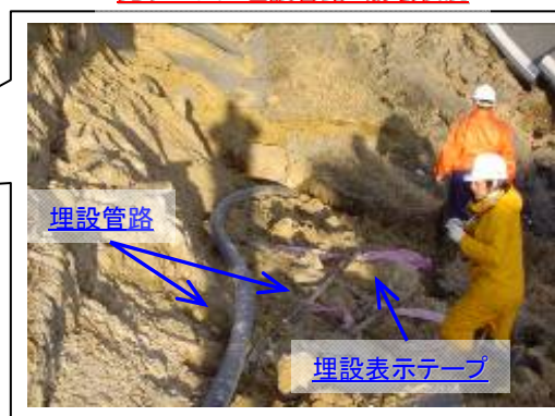
光ケーブル埋設管路 崩壊状況
