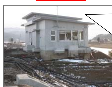
月浜第一水門局舎
