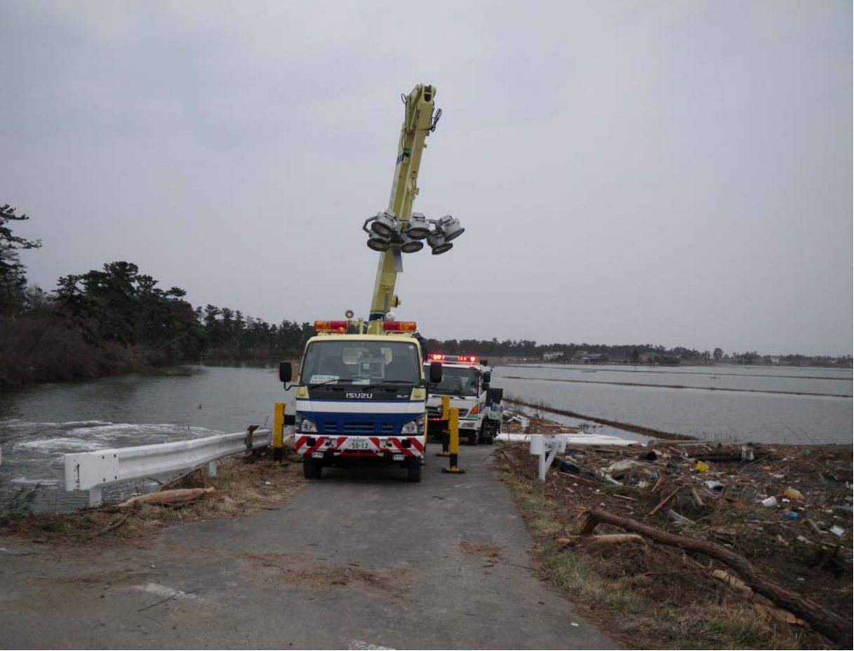
災害対策用稼働写真 3月20日 派遣箇所 ④ 排水ポンプ車(18-4891) 照明車(17-1876)
