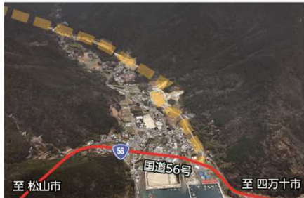
内海IC (仮称) 付近
