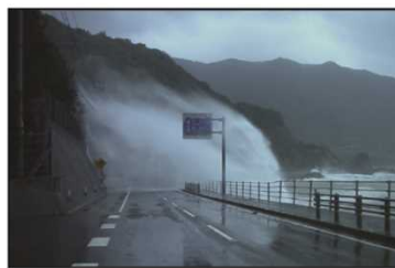
国道56号 (須ノ川地区) 越波状況
