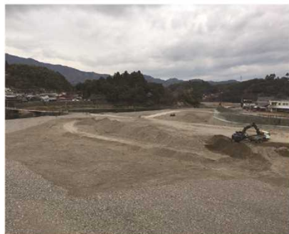
堆積土砂撤去
