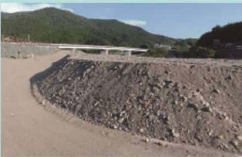
河道内に堆積した土砂の撤去
