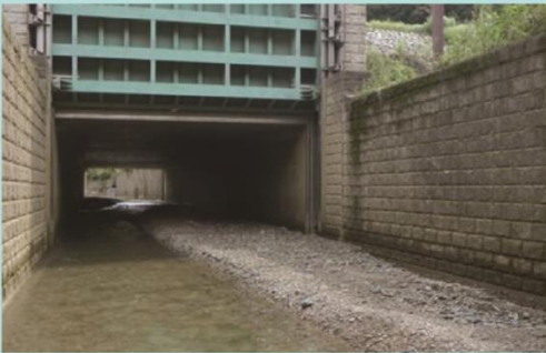
樋門に堆積した土砂の撤去
