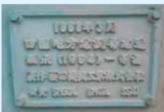
主桁の明示板
