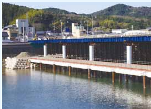
▲H28年3月末現在の工事の様子
