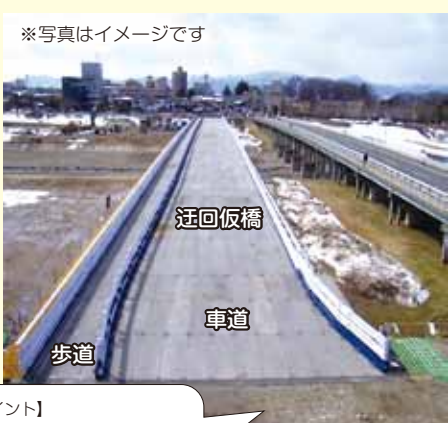
仮橋の完成です
