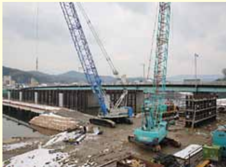
◀H28年1月現在の工事の様子
