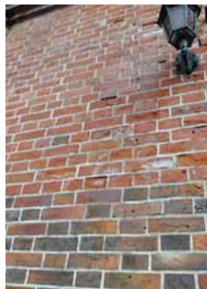
イギリス積みとフランス積み 上部がイギリス積み下部がフランス積み 赤と褐色のコントラストが美しい
