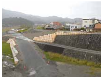
▲工事用道路設置完了（右岸側）
