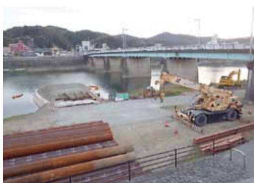
▲工事用仮橋着手前
