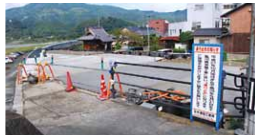
▲仮橋橋施工の為の工事用道路
