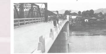
＜昭和36年 肱川橋改装工事＞
