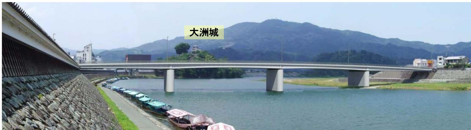
上部工は、左岸右岸の既存道路高さに合わせるため、桁高を低くおさえることが可能なプレビーム合成桁を採用しています。
