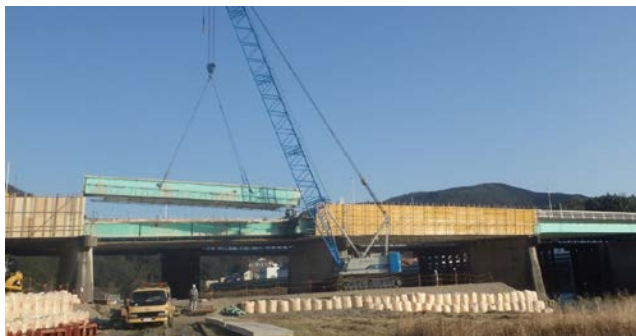
既設橋梁下部工撤去開始（平成29年2月）
