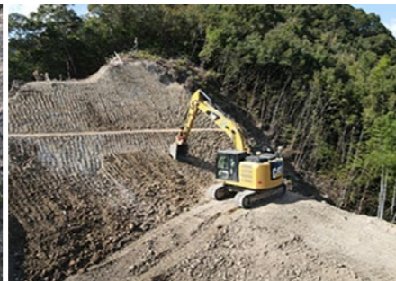
ICTバックボウによる掘削状況
