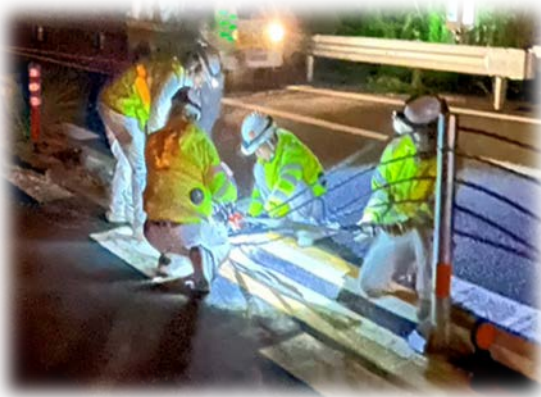
防護柵の復旧
