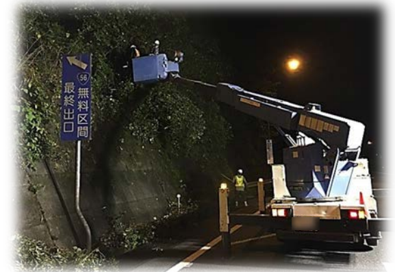
道路除草作業
