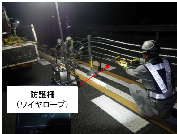
防護柵(ワイヤロープ)の設置
