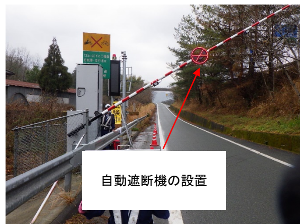
③自動遮断機設置
