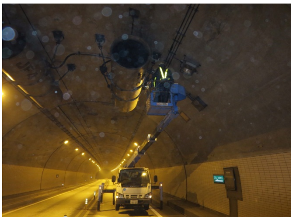
④トンネル点検
