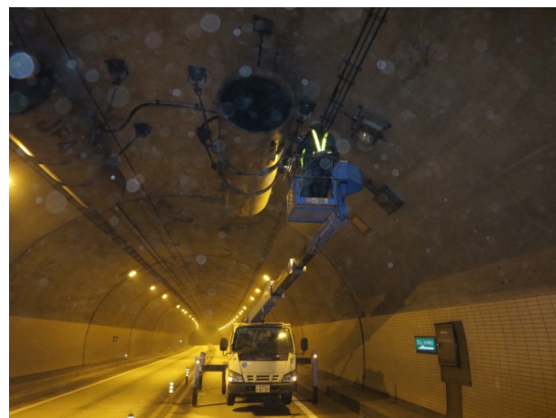
④トンネル点検
