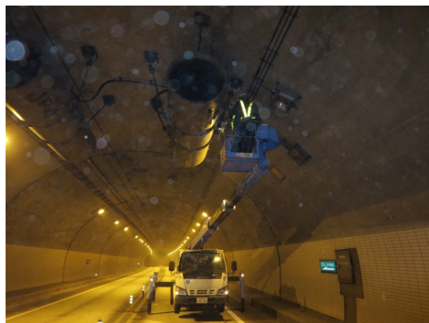
④トンネル点検
