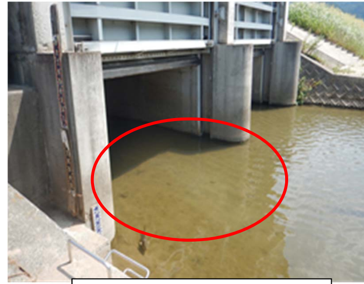
堆積土砂の撤去後 (大久保川樋門)
