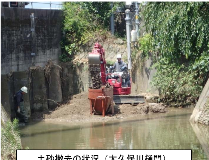
土砂撤去の状況 (大久保川樋門)
