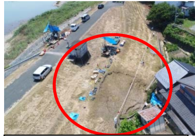
撮影された現地被災状況
