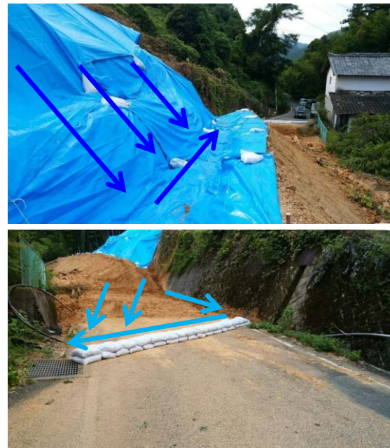
地すべり想定箇所外への雨水誘導(排水シート張り)
