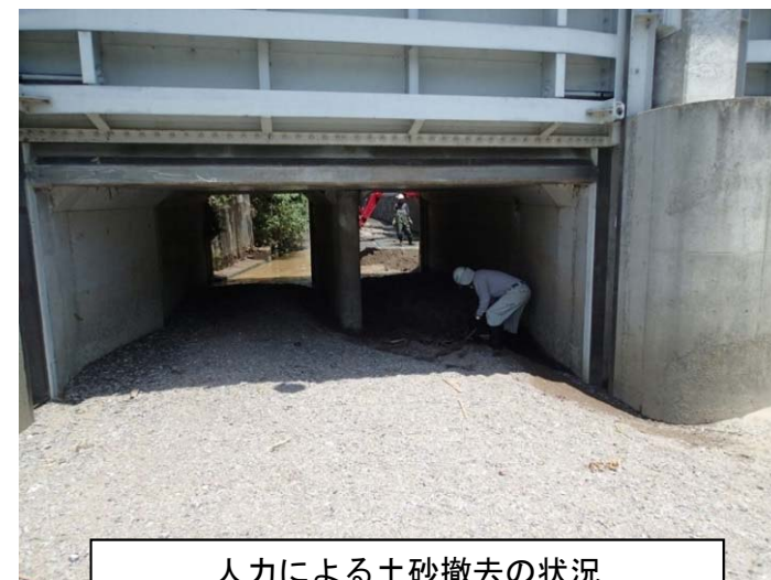
人力による土砂撤去の状況
