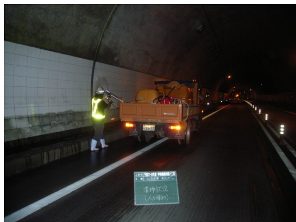
④トンネル清掃
