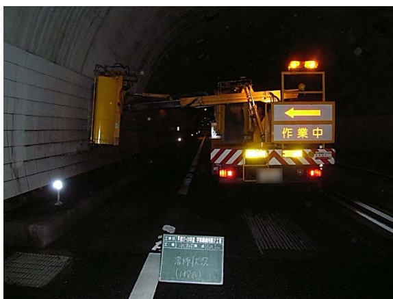
④トンネル清掃
