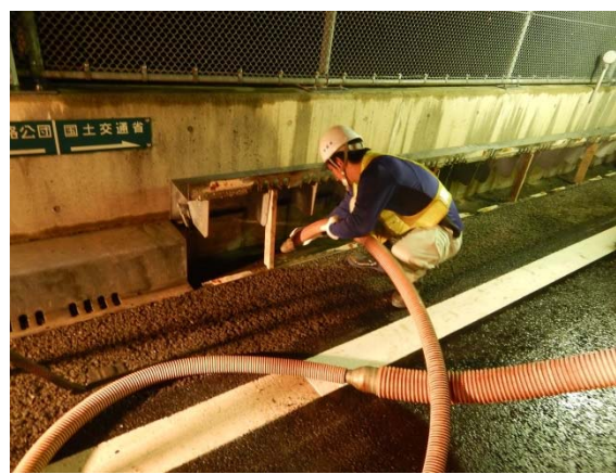
⑤排水構造物清掃
