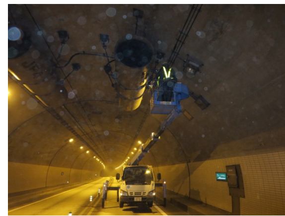
⑥トンネル設備点検
