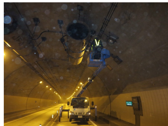
⑥トンネル設備点検
