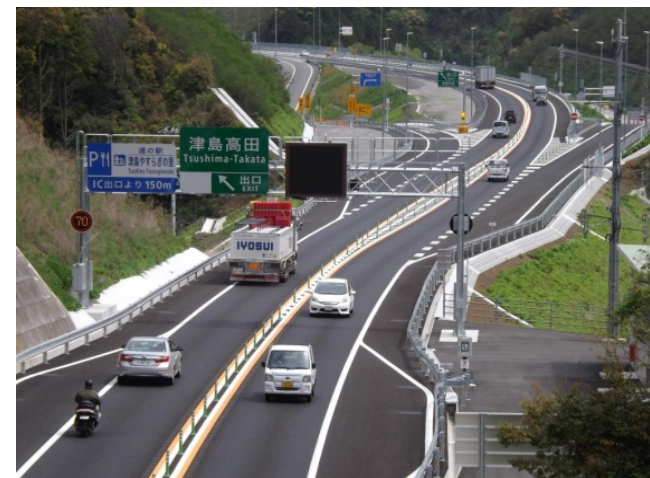
津島高田IC付近(松山方面向き) H27.4撮影 (鮮魚運搬車なども日常的に利用し全国へ出荷)
