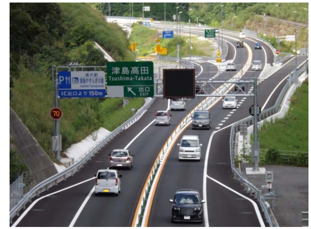
お盆中の津島高田IC付近(松山方面を望む)の状況
