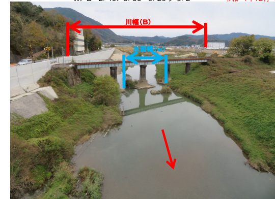
⑥ 生々橋上流部(生々橋より撮影) 新谷水位観測所：水位 0.59m 五郎水位観測所：水位 0.38m W/B=2.49/8.55=0.29 > 0.2 令和 4年12月 5日(月)14:00
