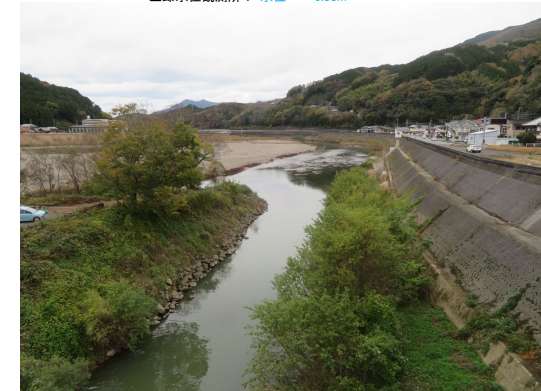
⑥ 生々橋上流部(生々橋より撮影) 新谷水位観測所：水位 0.59m 五郎水位観測所：水位 0.38m W/B=2.49/8.55=0.29 > 0.2 令和 4年12月 5日(月)14:00
