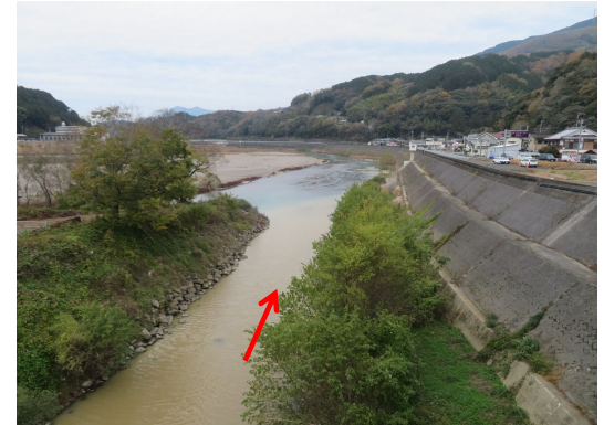
⑥ 生々橋上流部(生々橋より撮影) 新谷水位観測所：水位 0.58m 五郎水位観測所：水位 0.30m W/B=2.49/8.55=0.29 > 0.2 令和 4年12月 9日(金) 14:05
