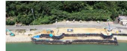
堤防工事状況写真(小長浜地区、護岸基礎工)
