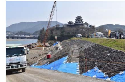
鋼矢板打設状況(左岸18.2k付近、川側)
