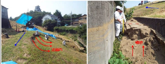
平成30年7月豪雨による堤防漏水被害(左岸18.2k周辺)
