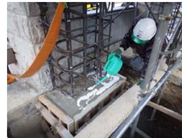
門柱補強工施工状況
