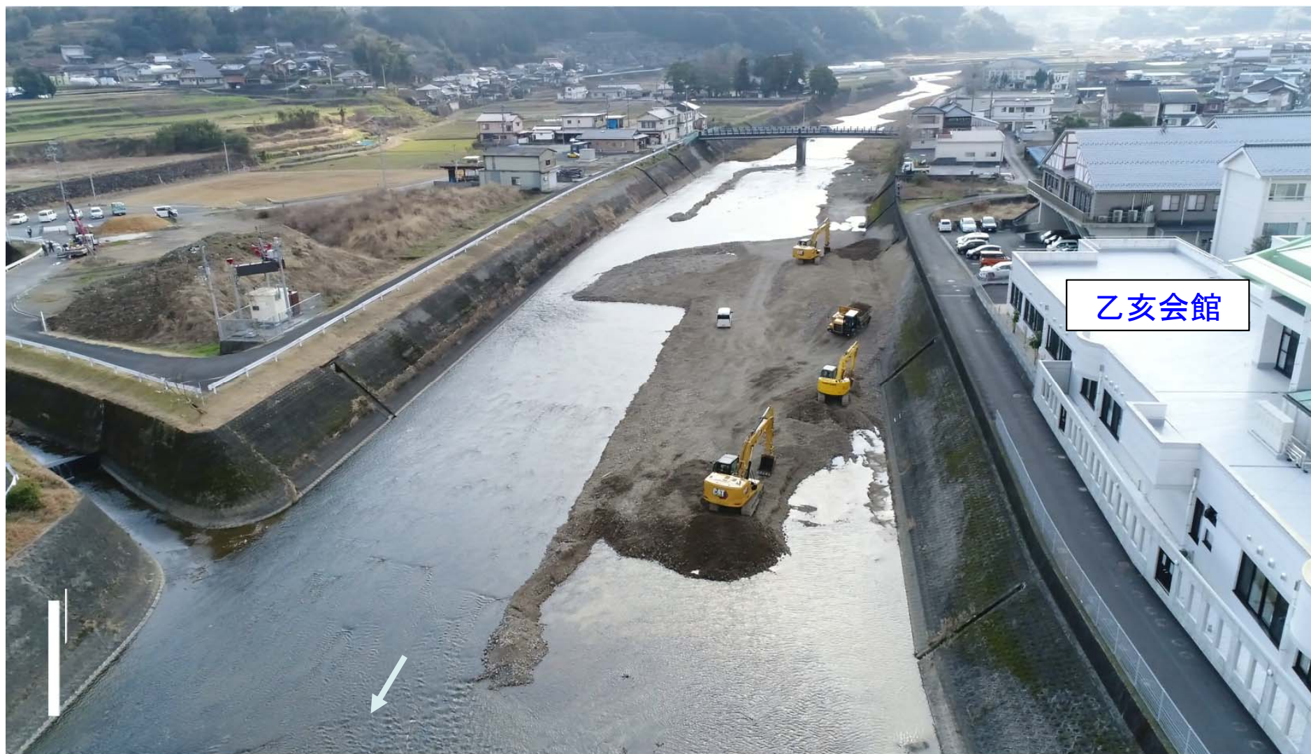
乙亥会館前から上流を望む R3. 2. 8撮影
