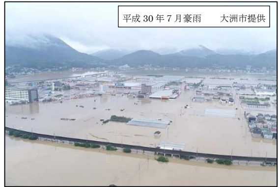
平成30年7月洪水による被害状況（東大洲）
